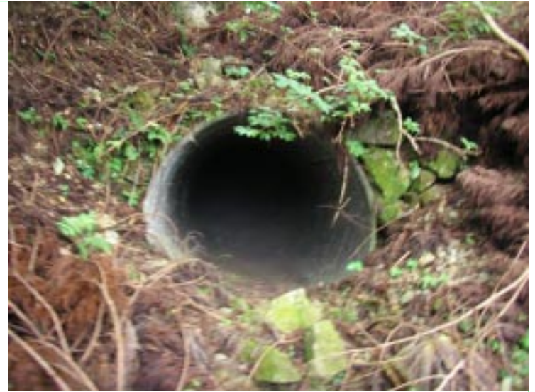
埋まったトンネル
